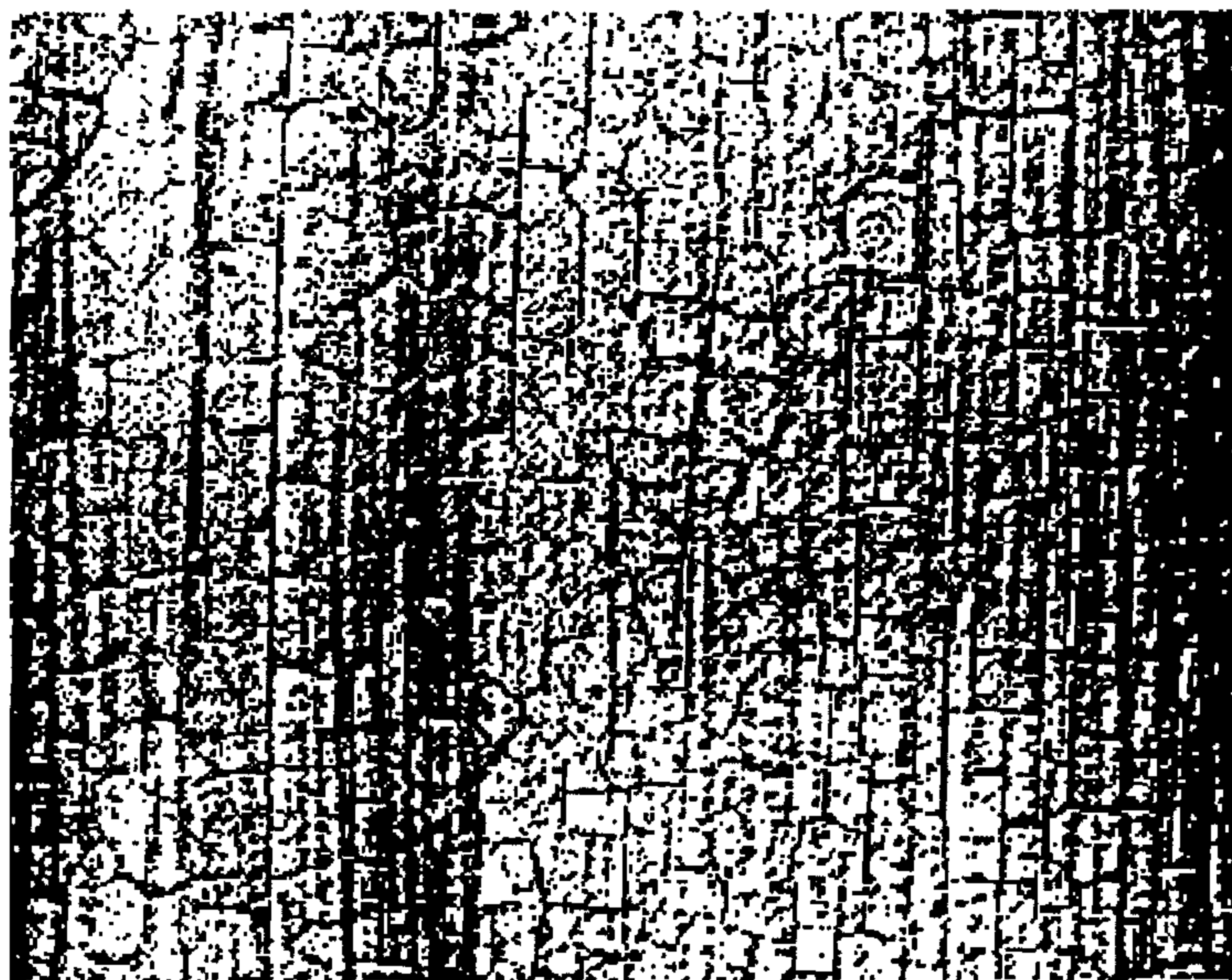
Рисунок 1 — Растрескивание лакокрасочного покрытия
